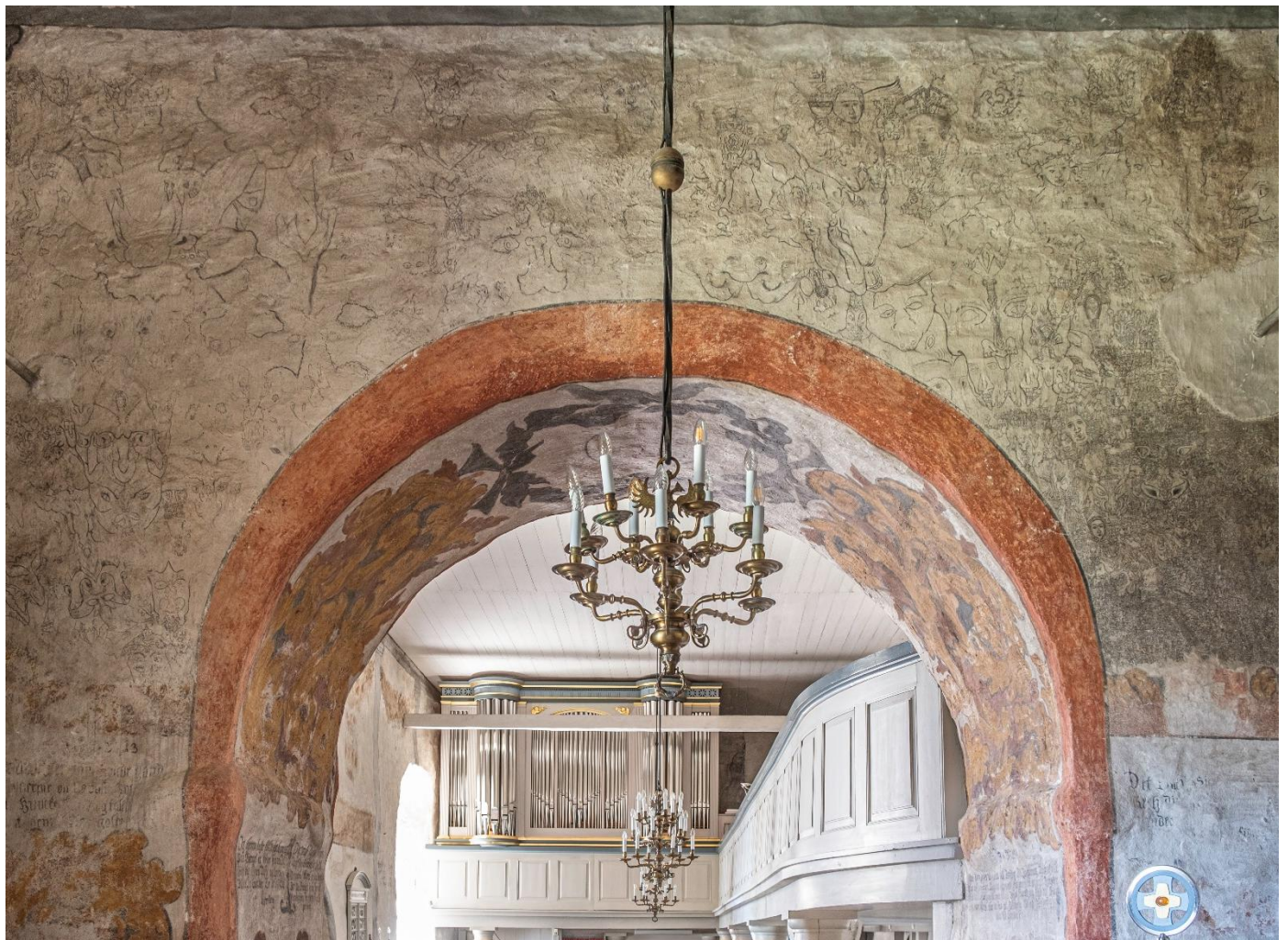
Demonveggen, slik presten ser den når ho står ved alteret og ser utover kyrkjelyden.
